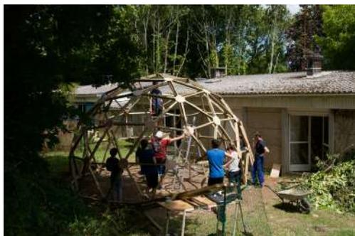
Photo 6 : Fabrication du dôme géodésique de KAL
